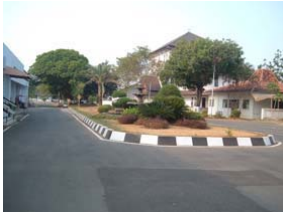
Gambar 4.1. Kondisi lingkungan perkantoran (Kantor Bupati Batang)
