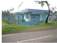
Gambar 3.6. Potret bangunan sumur dalam milik PDAM Batang
